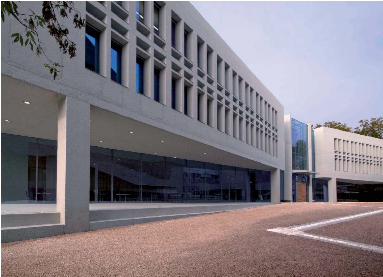
Das neue Seminargebäude entstand im Zuge der Umstellung auf Bachelor-/ Masterabschlüsse. In dem vom Architekturbüro Paul Böhm geplanten dreigeschossigen Gebäude sind 13 Seminarräume untergebracht. Die Bundesarchitektenkammer hat den Neubau als einen von 20 deutschen Beiträgen zur Architektubiennale 2011 in São Paulo ausgewählt. Foto: Architekturbüro Paul Böhm
